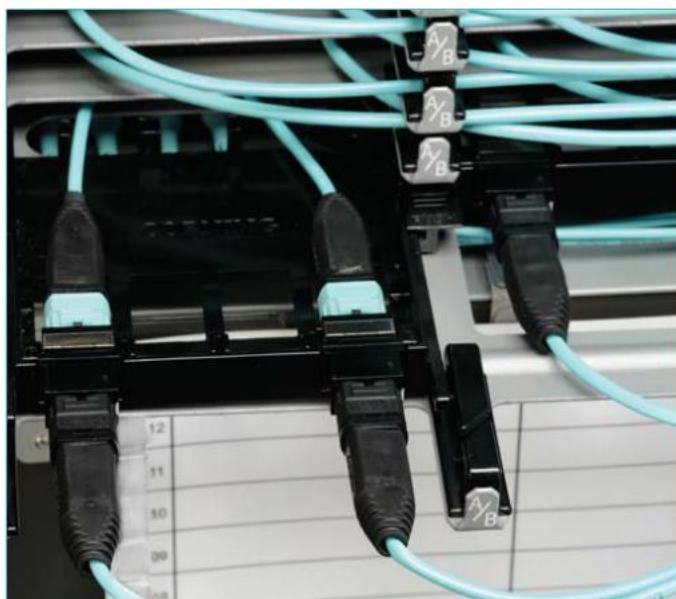
Pretium EDGE™ 解决方案MTP连接器面板，装载于配线架中
